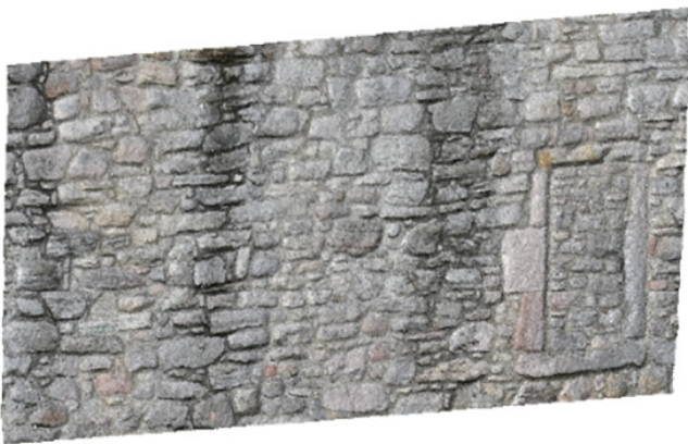
FIGURE 1 – Coupe rapprochée d'une section du Mur ouest de la Cour du palais de Linlithgow [4].
